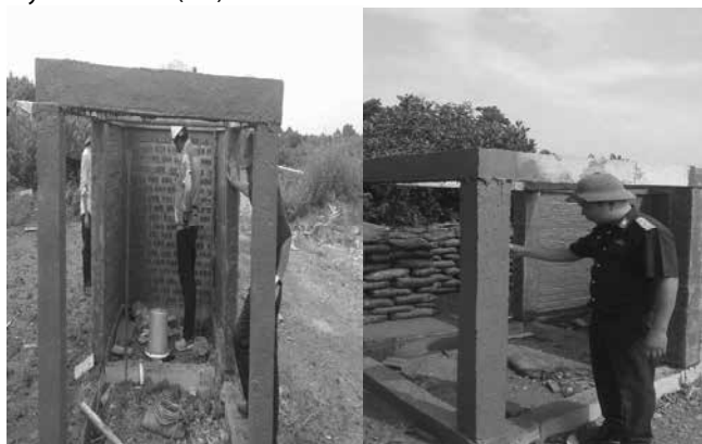
Hình 2. Mô hình thí nghiệm các kết cấu chính
