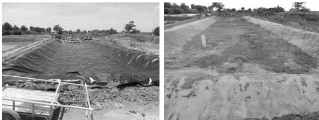
Hình 1: Đất ngập nước kiến tạo trong quá trình thi công
