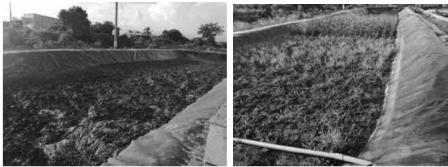
Hình 2: Đất ngập nước đã phủ lớp đất và trồng cây
