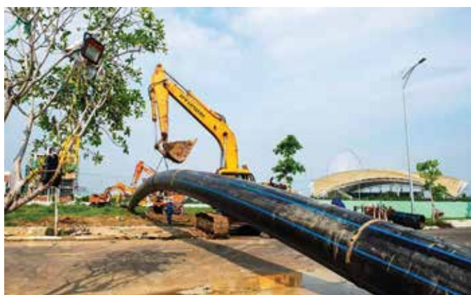
Công trình khoan ngầm dẫn hướng qua sông Hàn- Đà Nẵng- dự án ứng dụng khoan ngầm dẫn hướng của TNG năm 2019.
