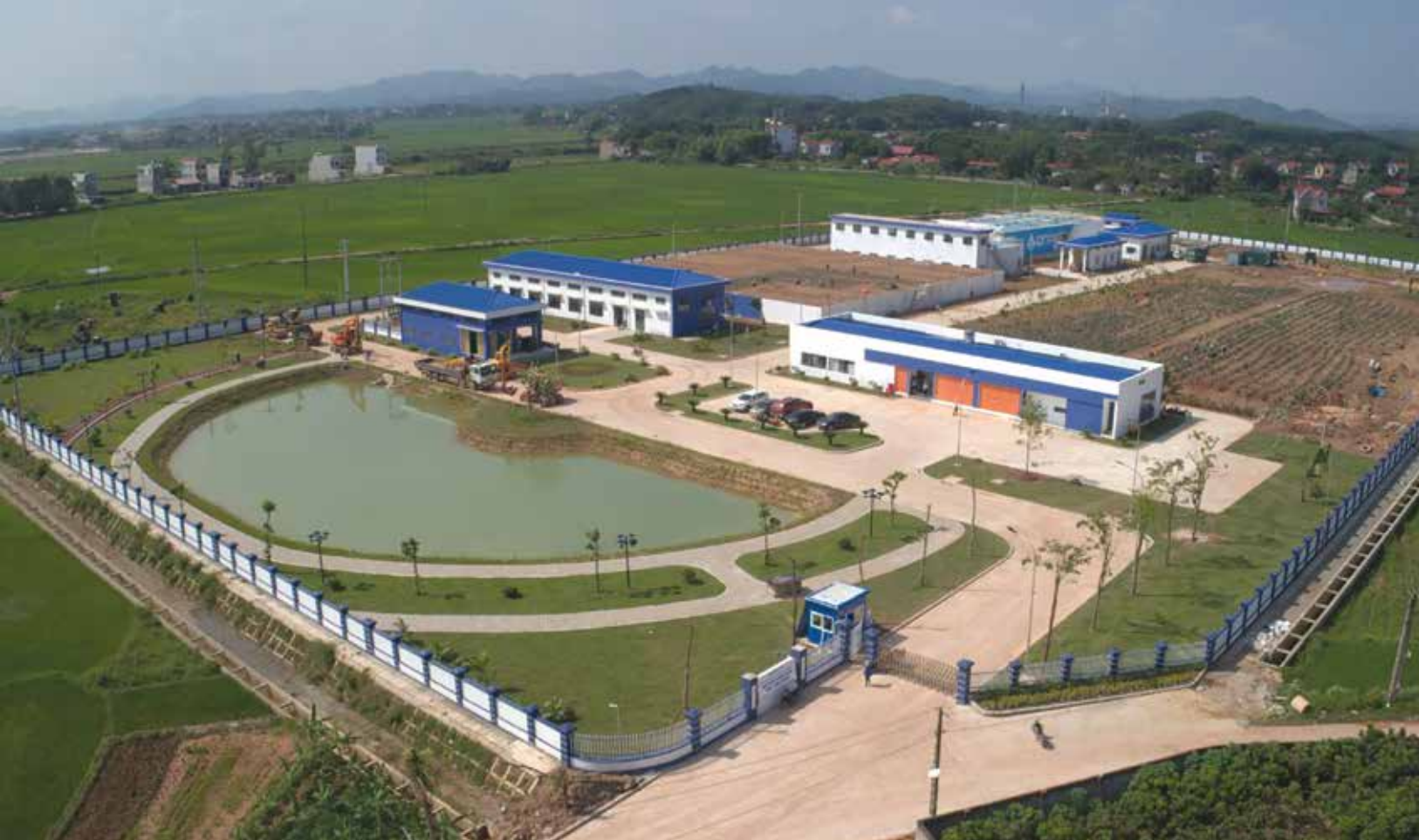
Công trình Nhà máy nước Bắc Giang được TNG hoàn thiện từ năm 2018, đang được vận hành ổn định truyền tải mạng nước cấp 2.
