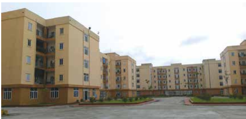
Cụm nhà ở sinh viên tập trung thành phố Nam Định được khởi công xây dựng vào tháng 12/2009 hoàn thành và đưa vào sử dụng tháng 6/2014.
