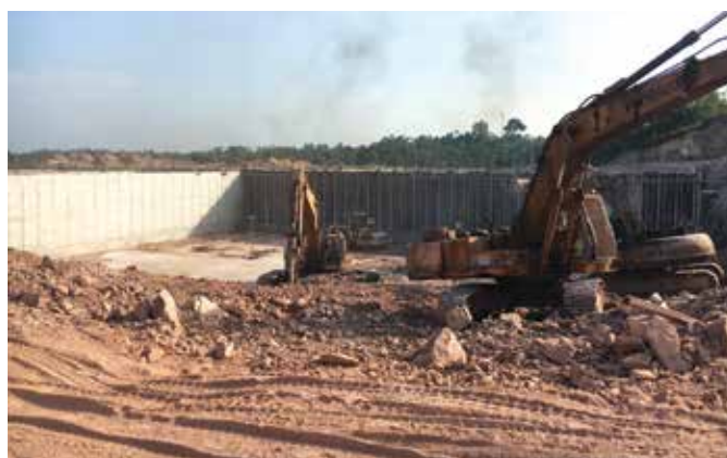
TNG thi công hạng mục bể chứa 40.000 m 3 - dự án Nhà máy nước Vạn Niên.
