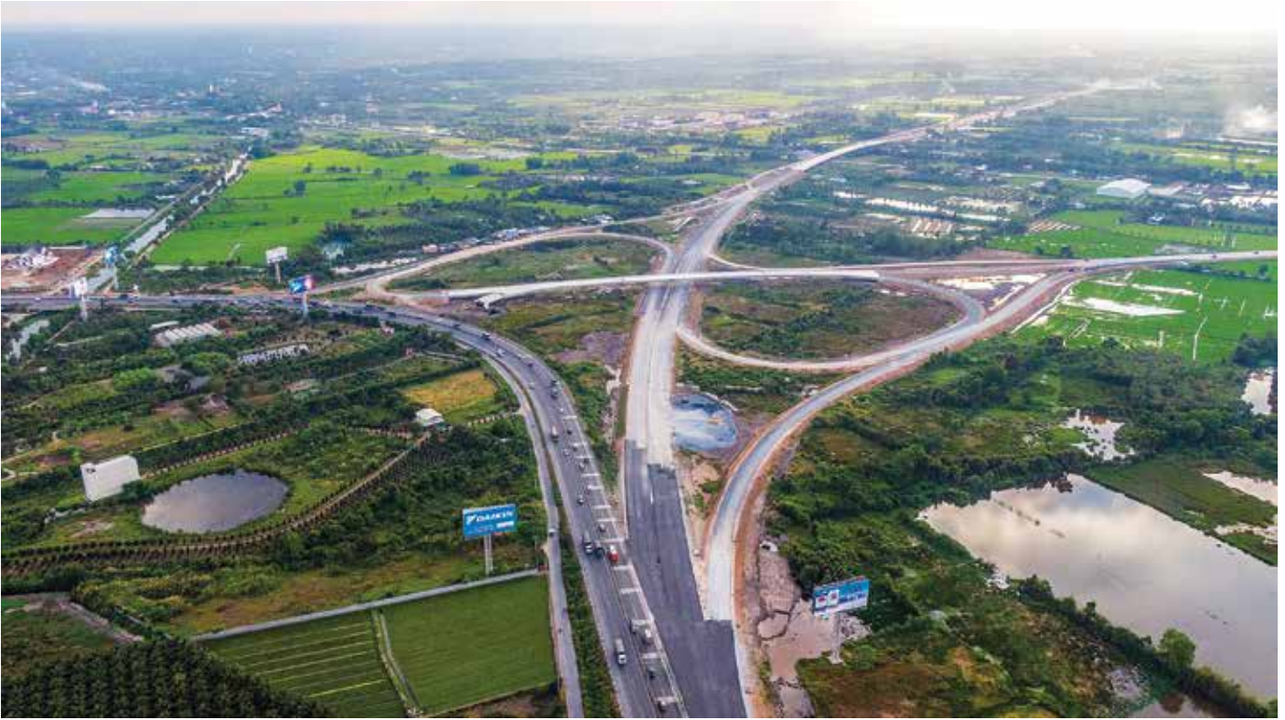
Dự án cao tốc Trung Lương - Mỹ Thuận, kinh phí thực hiện trên 14.000 tỷ đồng đang trong giai đoạn hoàn thiện. Đây sẽ là bước ngoặt lớn giải bài toán kẹt xe trên tuyến quốc lộ 1 kết nối miền Tây với TP.HCM.
