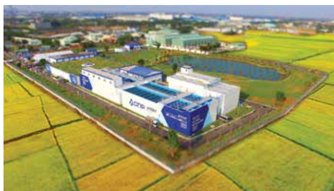
Nhà máy nước Nhi Thành, Long An công suất 60.000 m 3 /ngày.
