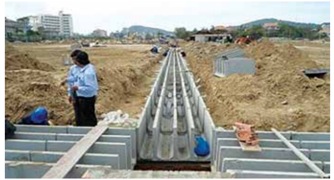
Hào tuynel kỹ thuật để tránh tình trạng đào lấp đường
