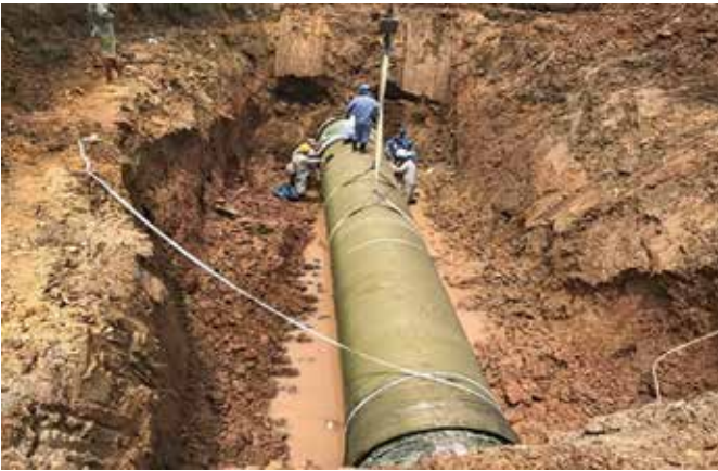
Hình 1: Sửa chữa đường ống nước sông Đà bị vỡ
