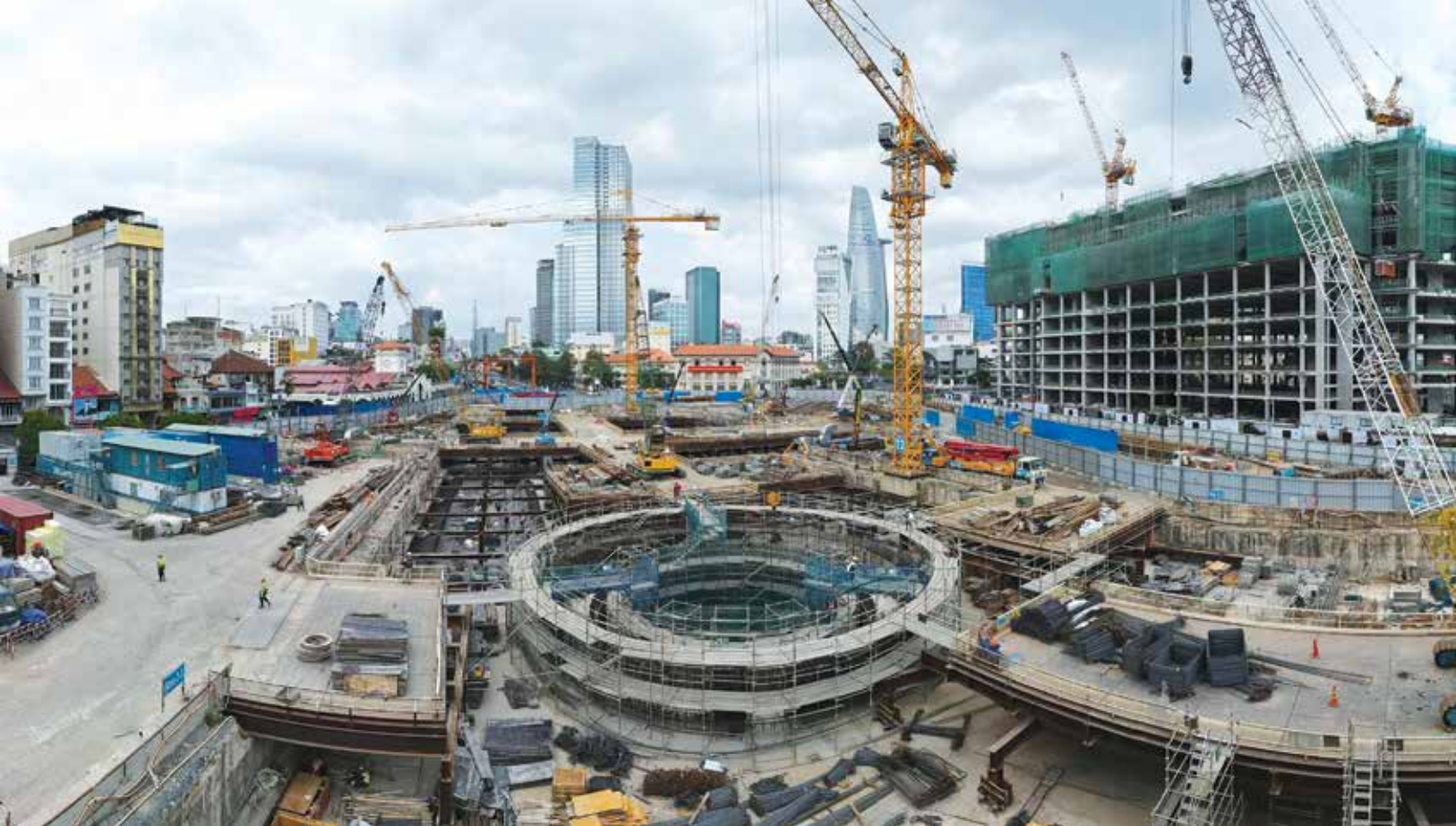
Sau gần 5 năm thi công, nhà ga metro trung tâm Bến Thành (quận 1, TP.HCM) đang dần hoàn thiện.
