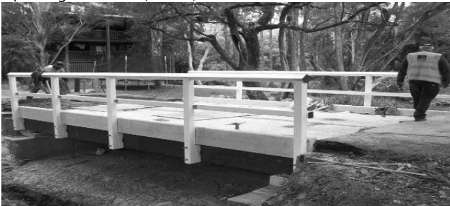
Hình 2. Ứng dụng bê tông GPC làm sàn cầu tại Brisbane, Úc [4].
