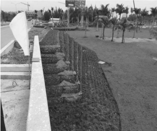
Hình 9. Trồng cỏ trên mặt tường chắn rọ đá
