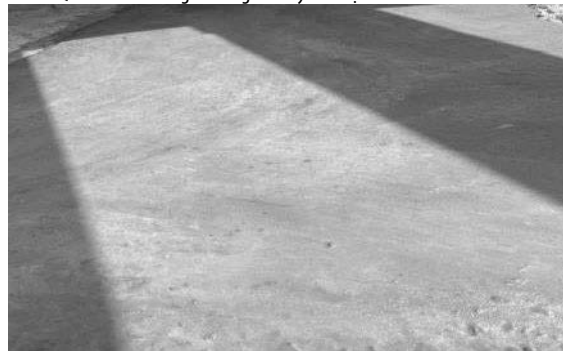
Hình 11. Bề mặt kết cấu sau khi thi công gia cường bê tông tro bay cát mịn
