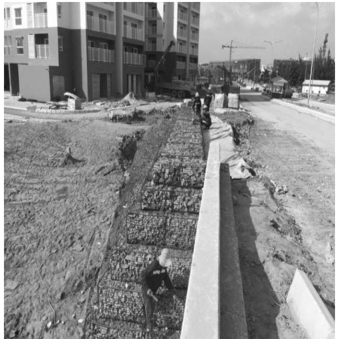
Hình 8. Rọ đá vỏ lưới nhựa được xếp nhiều lớp làm tường chắn đất
