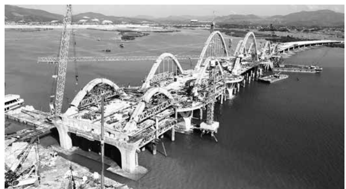
Tiến độ thi công cầu Cửa Lục 1 ngày 6/10/2021.
