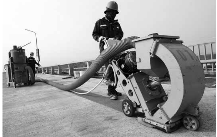
Bắn bi thép tuần hoàn tạo độ nhám 300µm mặt lớp UHPC liên hợp.
