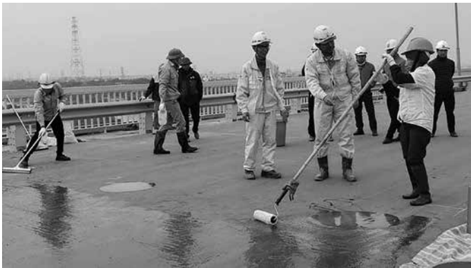
Quét keo Epoxy nhiệt dẻo để tăng cường bám dính cho lớp Polymer Asphalts.
