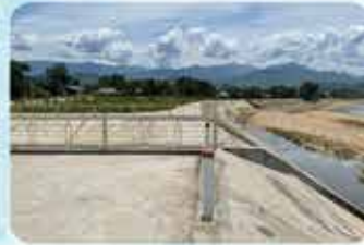
Công trình Kè Suối Thia Nghĩa Lộ-Yên Bái
