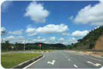
Công trình Đường dẫn Cầu Tuấn Quán - Yên Bái
