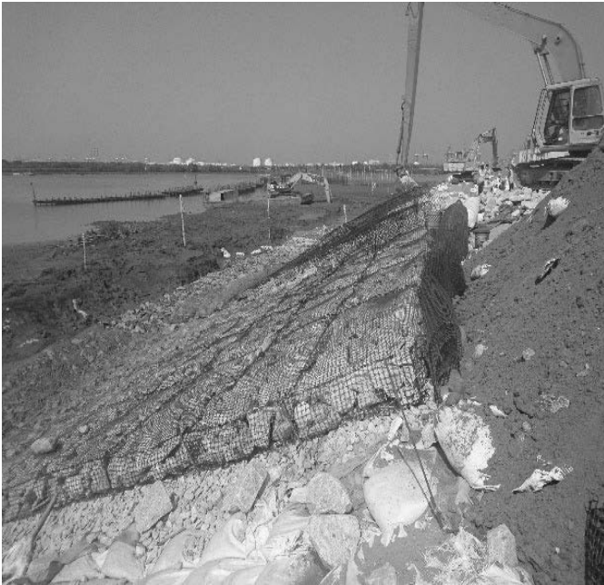
Hình 7. Thi công rọ đá vỏ lưới nhựa bề mặt ta luy
