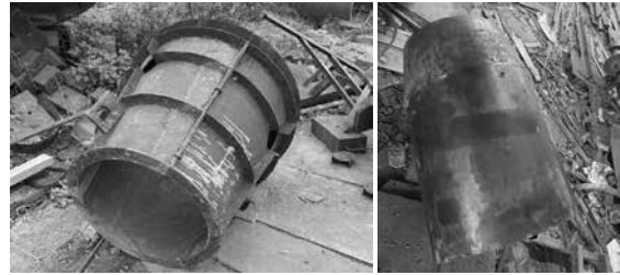
Hình 9. Ván khuôn ngoài và trong của khối đỉnh trước và sau khi lắp ghép
