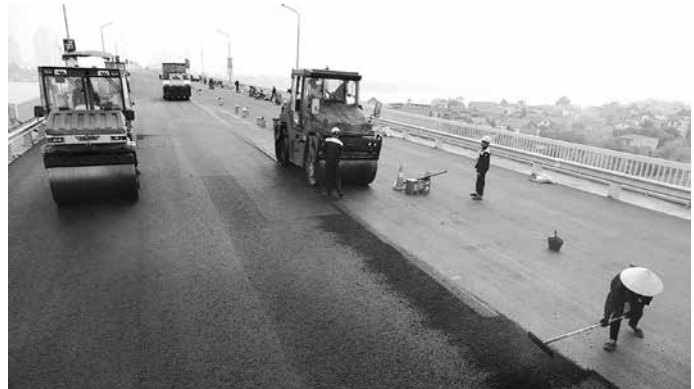
Thi công lớp phủ Polymer Asphalts nhựa nóng.
