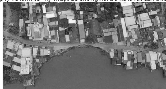
Hình 1. Sạt lở bờ sông ở ĐBSCL
