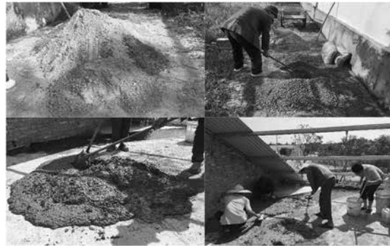
Hình 10. Quá trình thi công bê tông tro bay cát mịn
