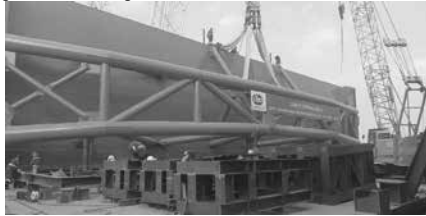
Hình 14. Cửa van cống Cái Lớn được tổ hợp trên bãi sau đó cấu lắp đặt vào vị trí công trình
