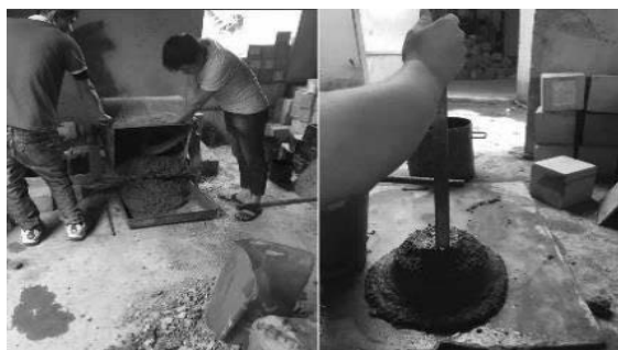
Hình 6. Trộn bê tông và đo độ sụt
