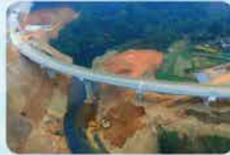
Công trình Cầu Bến Nước Hùng Lợi - Yên Sơn Tuyên Quang
