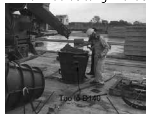
Hình 11. Đổ bê tông khối đỉnh
