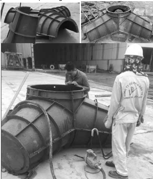
Hình 8. Ván khuôn ngoài khối đế trước và sau khi ghép
