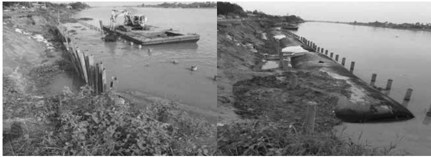
Hình 6. Bờ kè mềm BST đê vùng III xã Vĩnh Trường, huyện An Phú, tỉnh An Giang
