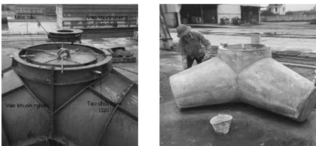
Hình 13. Khối đá trong quá trình đổ bê tông và sau khi tháo ván khuôn
