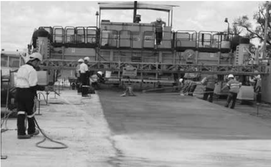
Hình 1. Sân bay Wellcamp xây dựng bằng bê tông GPC [4]
