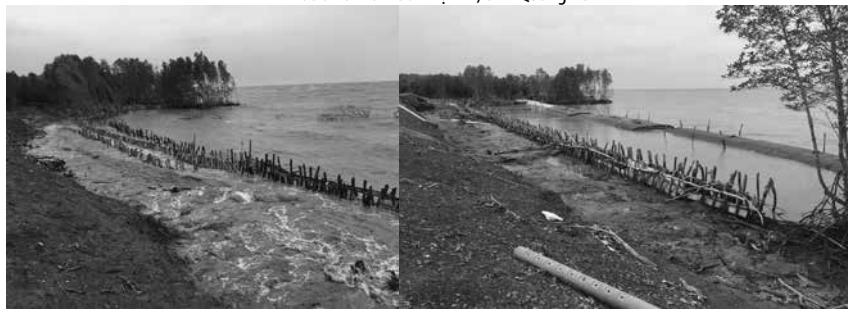
Hình 8. Bờ kè mềm BST Kê đê biển Tây, Trần Văn Thời, tỉnh Cà Mau
