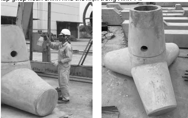
Hình 14. Khối đá hình tứ giác sau khi lắp ghép, bảo dưỡng và hoàn thiện
