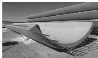
Hình 2.8. Trụ BTCT phân đoạn dài mỗi nối khô - [53]
