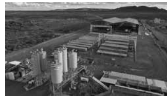
Hình 3.10. Nhà máy cấu kiện BTCT phân đoạn dài ACCIONA - [53]
