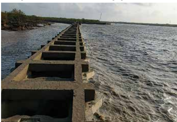
Kè biển tây Cà Mau bằng công nghệ bê tông cốt phi kim Busadco.
