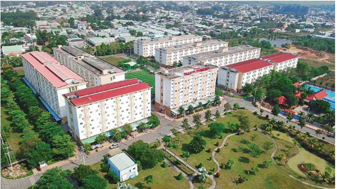
Khu nhà ở công nhân KCN Nhơn Trạch do IDICO xây dựng từ năm 2013.
