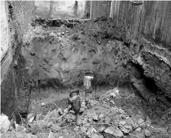
Hình 5. Phá bỏ nền cũ trước khi ép cọc
