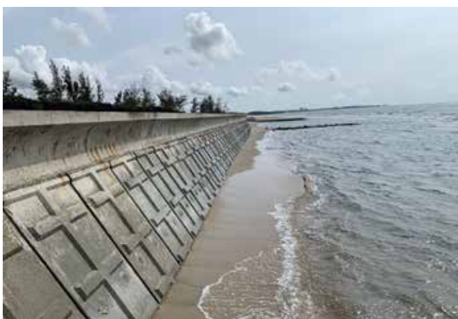
Kè Làng Chài-Xuyên Mộc bằng công nghệ bê tông cốt phi kim Busadco.
