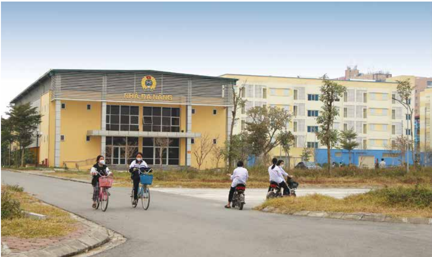
Khu Thiết chế công đoàn Hà Nam, được xây dựng trên địa bàn KCN Đồng Văn II.
