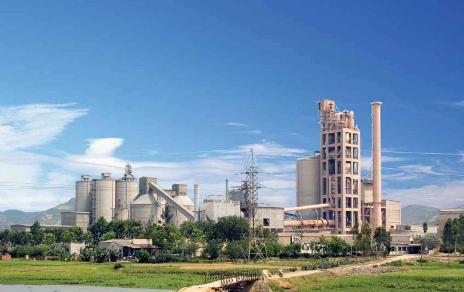
Nhà máy Xi măng Hoàng Mai.
