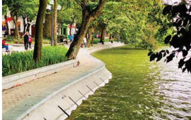
Kè hồ Hoàn Kiếm bằng công nghệ bê tông cốt phi kim Busadco.
