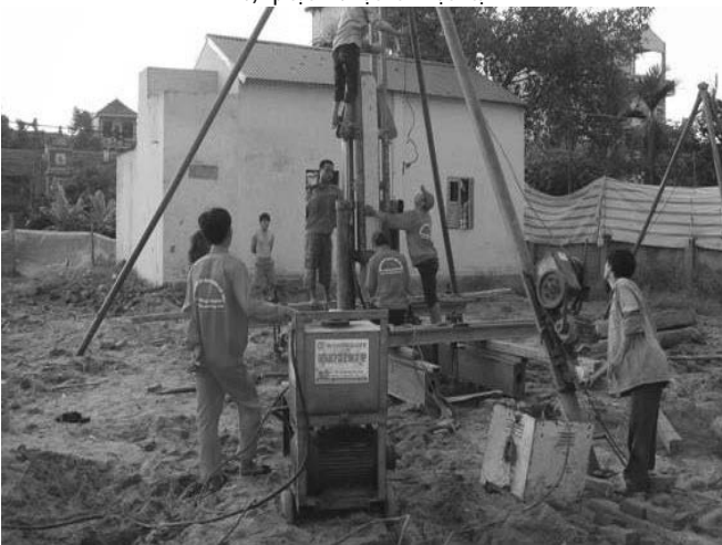
b) Ép cọc khu vực mới san lấp
