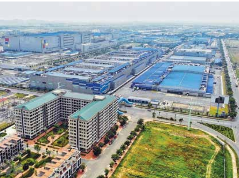
H2. Nhà ở, nhà cho công nhân thuê tại KCN Yên Phong, Bắc Ninh.
