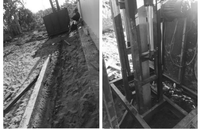
Hình 6. Làm bằng phẳng nền và ép cọc
