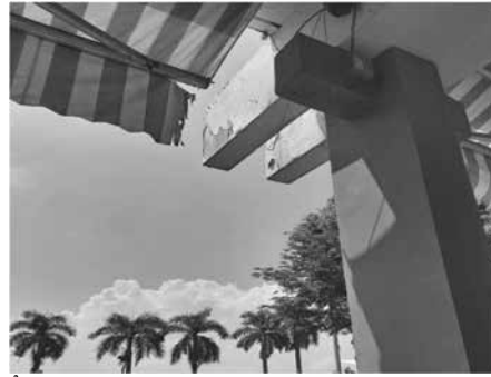
Ảnh 14. Kết cấu đặc trưng của HTCKĐS SAE với 2 dầm đua cùng cột có gối đỡ
