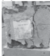
(b) Mẫu bê tông bị phá
