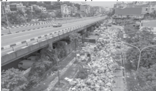
Hình 2: Bãi rác dài gần 200m ngay dưới chân cầu Bãi Cháy - Quảng Ninh
