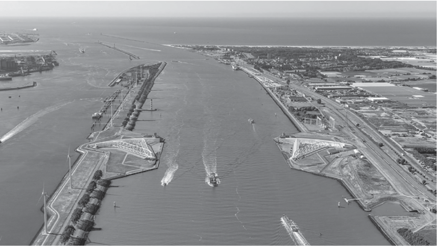
Hình ảnh hệ thống đê biển và công quay chống ngập Maeslantkering tại TP Rotterdam (Hà Lan)
