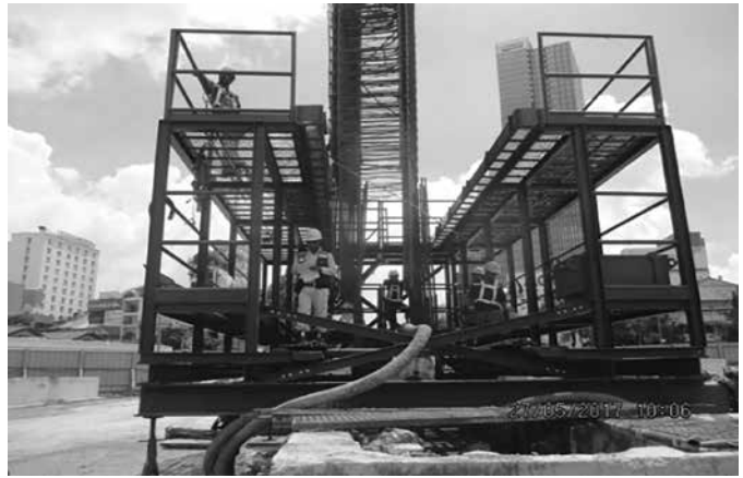
Hình 5. Hệ giàn giáo 2 tầng, di động lắp đặt trên đỉnh tường.
