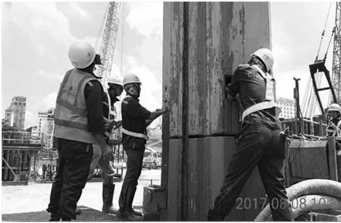
Hình 3. Thanh cốt pha lắp đặt giằng ngăn nước.
