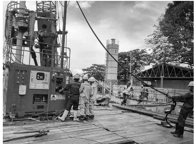
FECON UCC thi công gia cố tại khu vực tiếp nhận TBM (Arriving shaft) tại dự án Metro line 1 Bến Thành - Suối Tiên bằng công nghệ Jet Grouting 3 pha đường kính lớn.
