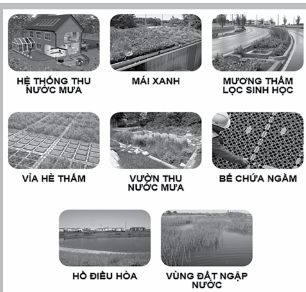
Hình 2. Một số biện pháp SUDS áp dụng với các quy mô khác nhau.
