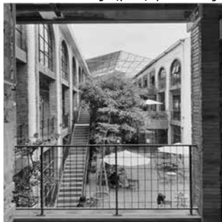
Nhà máy phố Tây Sơn
