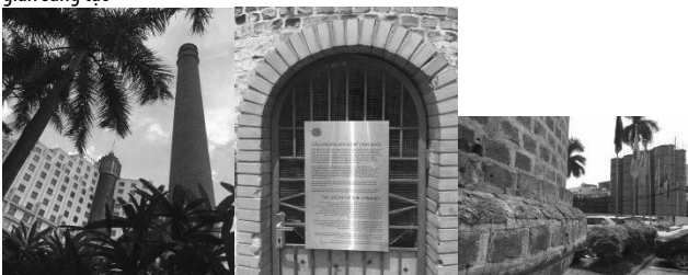
Hình 4- Ống khói Cát Linh - được xây dựng trên khu đất một nhà máy gạch, phương án thiết kế để xuất giữ nguyên ống khói nhà máy - hình ảnh chủ chốt gợi lại lịch sử đồng thời cũng là yếu tố cảnh quan đặc biệt cho khu vực.
