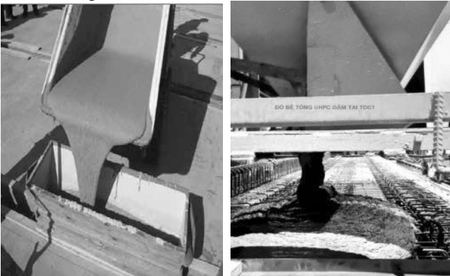
Hình 4. Tính tự chảy, tự lên chặt của hỗn hợp UHPC trong thực tế thi công
