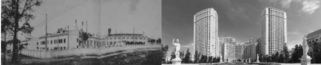
Nhà máy công cụ số 1 (~1970) - trước và sau chuyển đổi
