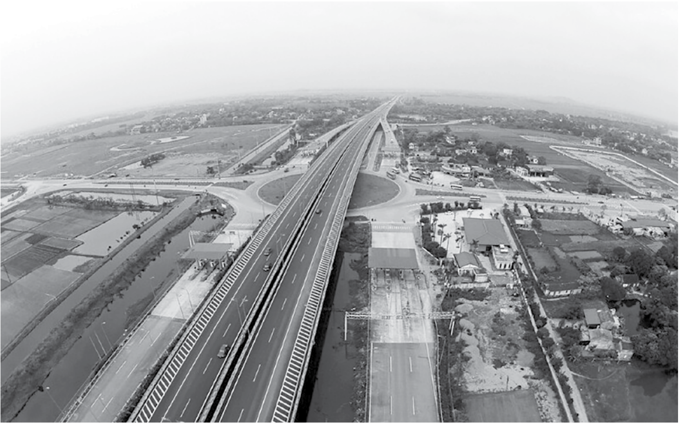
Một phần dự án cao tốc Bắc - Nam đang được hoàn thiện.
