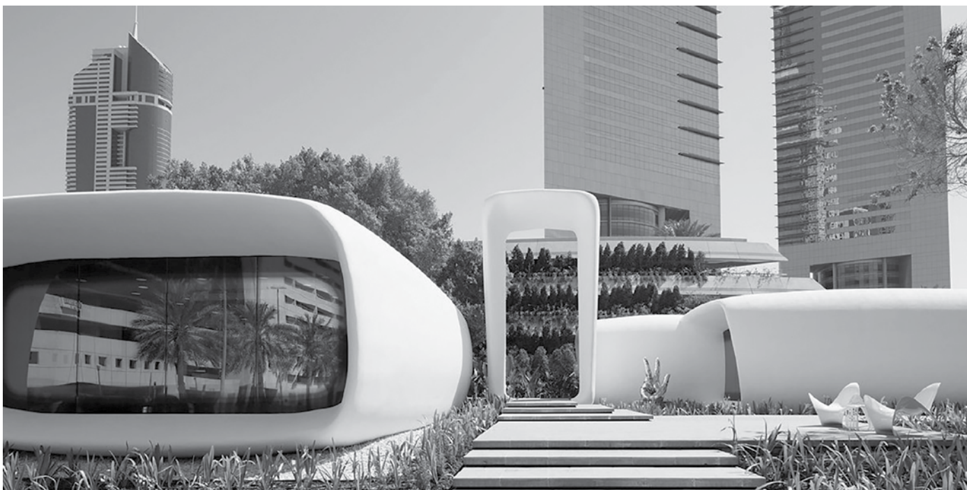
Tòa nhà in 3D bằng bê tông thật lớn nhất tại Dubai.
