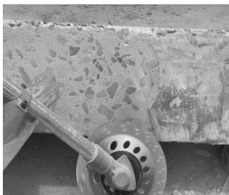
Hình 5. Làm nhẵn mặt dầm bằng máy mài cầm tay
