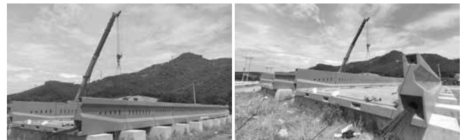
Hình 1. Dầm cốt UHPC chữ U ứng suất trước căng sau được chế tạo lần đầu tiên tại Việt Nam
