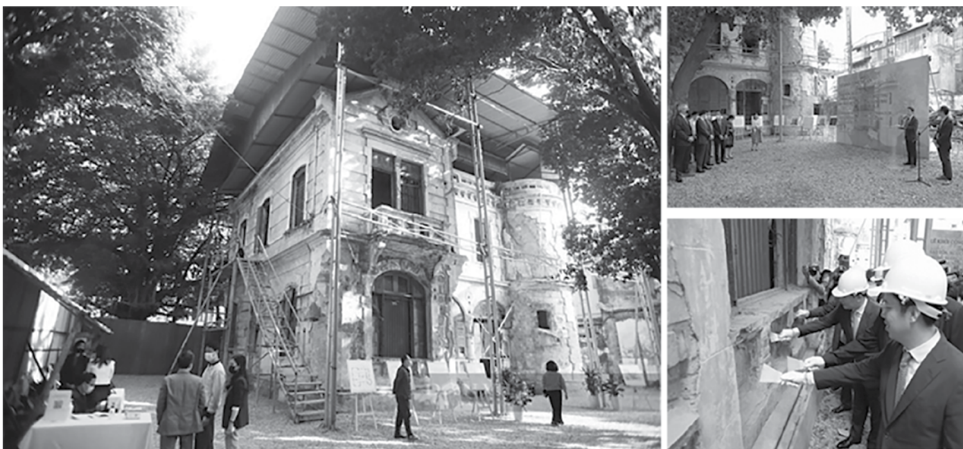
Hình 4: Công trình và lễ khởi công dự án trùng tu biệt thự cũ tại 49 Trần Hưng Đạo với chức năng mới là Trung tâm giao lưu văn hóa khu phố cũ sau khi hoàn thành (nguồn: internet)
