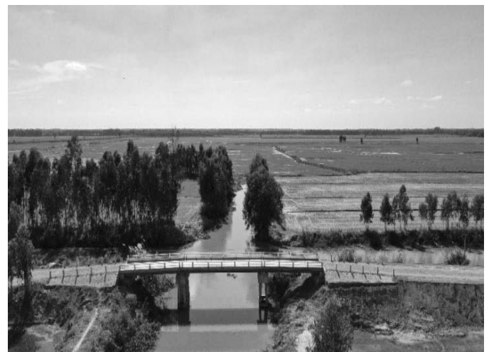
Hình 2. Một trong nhiều cây cầu UHPC được xây dựng gần đây tại vùng đồng bằng sông Cửu Long
