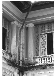
Hình 13. Hệ thống thu nước [1]
