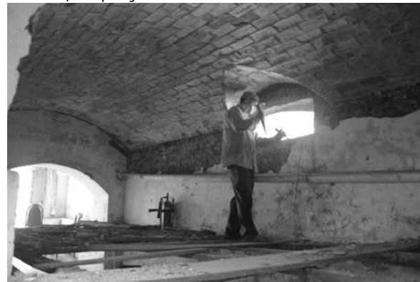
Hình 24. Đục bỏ phần hư mục của tầng hầm [2]
