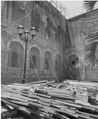
Hình 17. Thay thế hệ cấu tạo mái
