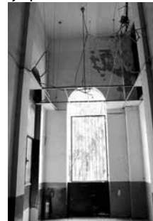
Hình 11. Hệ thống dây điện chằng chịt [1]
