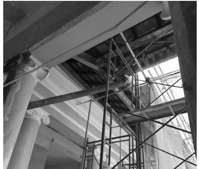
Hình 26. Thay mới hệ thống thu nước
