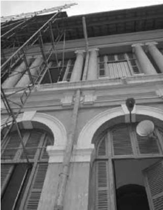
Hình 7. Hiện trạng tường, cửa [1]
