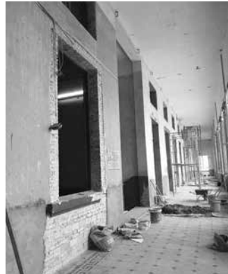
Hình 18. Trát bả, sơn lại tường [2]
