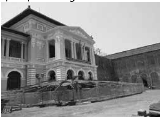
Hình 15. Mái che bộ phận được phục hồi
