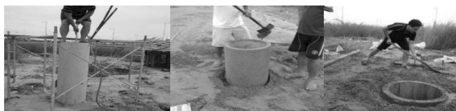
Hình 5. Quá trình lắp đặt ống giếng
