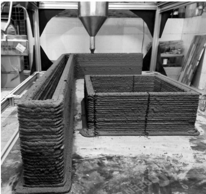
Hình 5. Máy in 3D được sử dụng để tạo hình các cấu kiện bê tông
