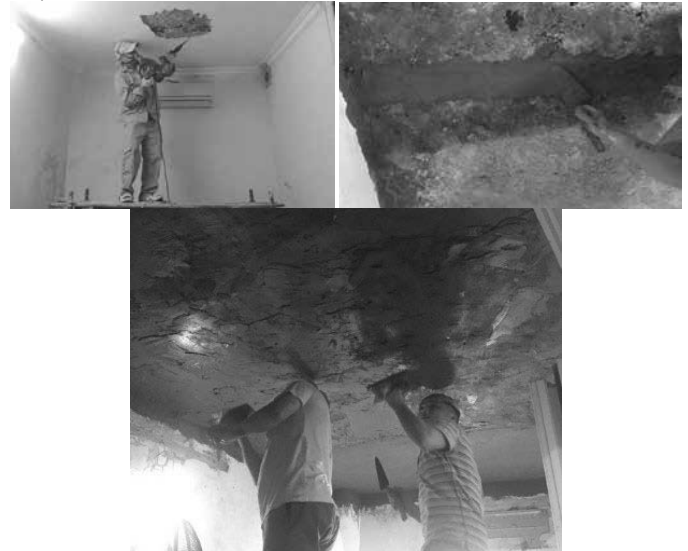
Hình 4. Sửa chữa lớp vữa và bê tông phủ bảo vệ ngoài kết cấu
