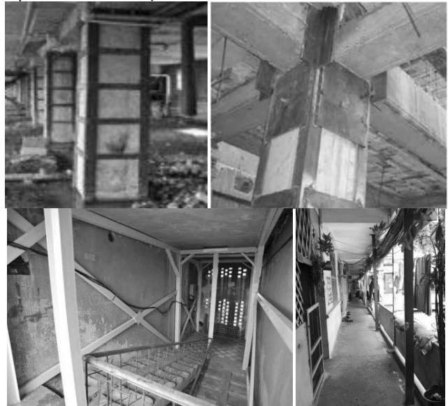
Hình 9. Gia cố kết cấu công trình bằng cốt thép hình
