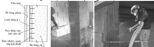
Hình 7. Phun bê tông tăng cường tiết diện kết cấu chịu lực
