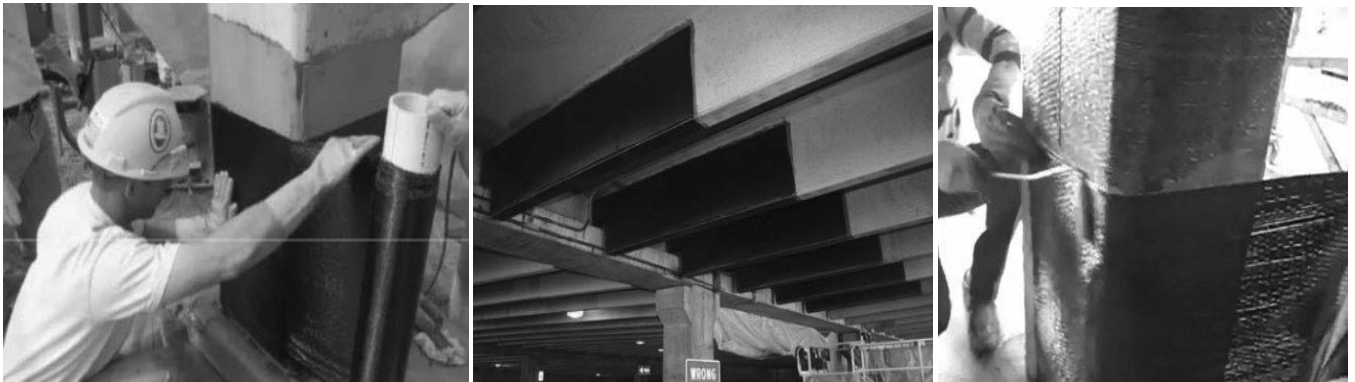
Hình 11. Gia cố kết cấu bằng vật liệu sợi Composite FRP
