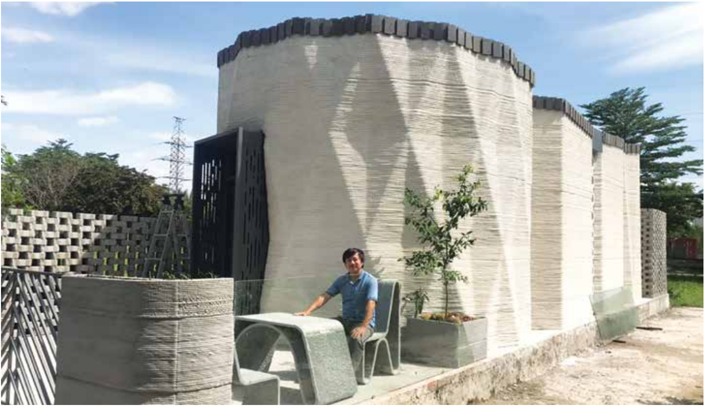
Chủ thích ảnh: Công trình đầu tiên in 3D ở TP.HCM, kích thước 5x14m và cao 4m.
