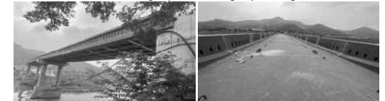
Hình 21. Một phần cầu sau khi đã hoàn thiện lao lắp dầm
