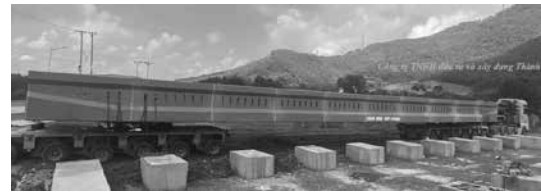
Hình 20. Dầm sau khi đã được ghép nối và căng cáp dự ứng lực
