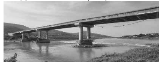
Hình 22. Cầu Vàng 4 nhịp x30m đã hoàn thành (chụp ngày 27/9/2022)
