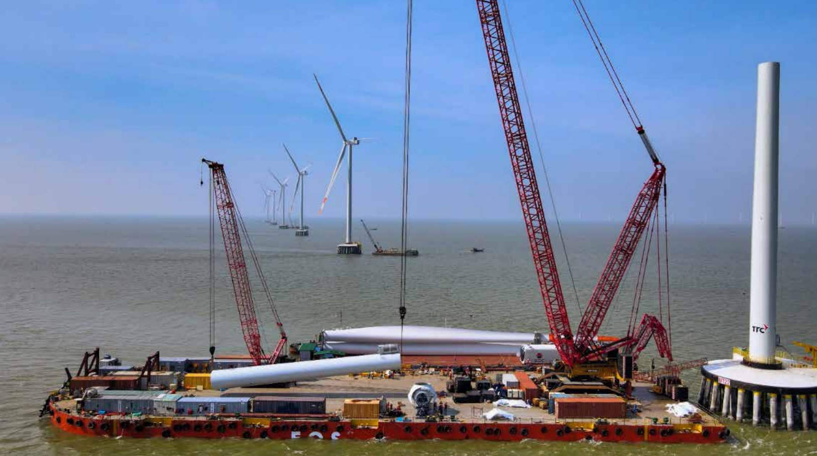
Dựng trụ và lắp cánh turbine gió.
