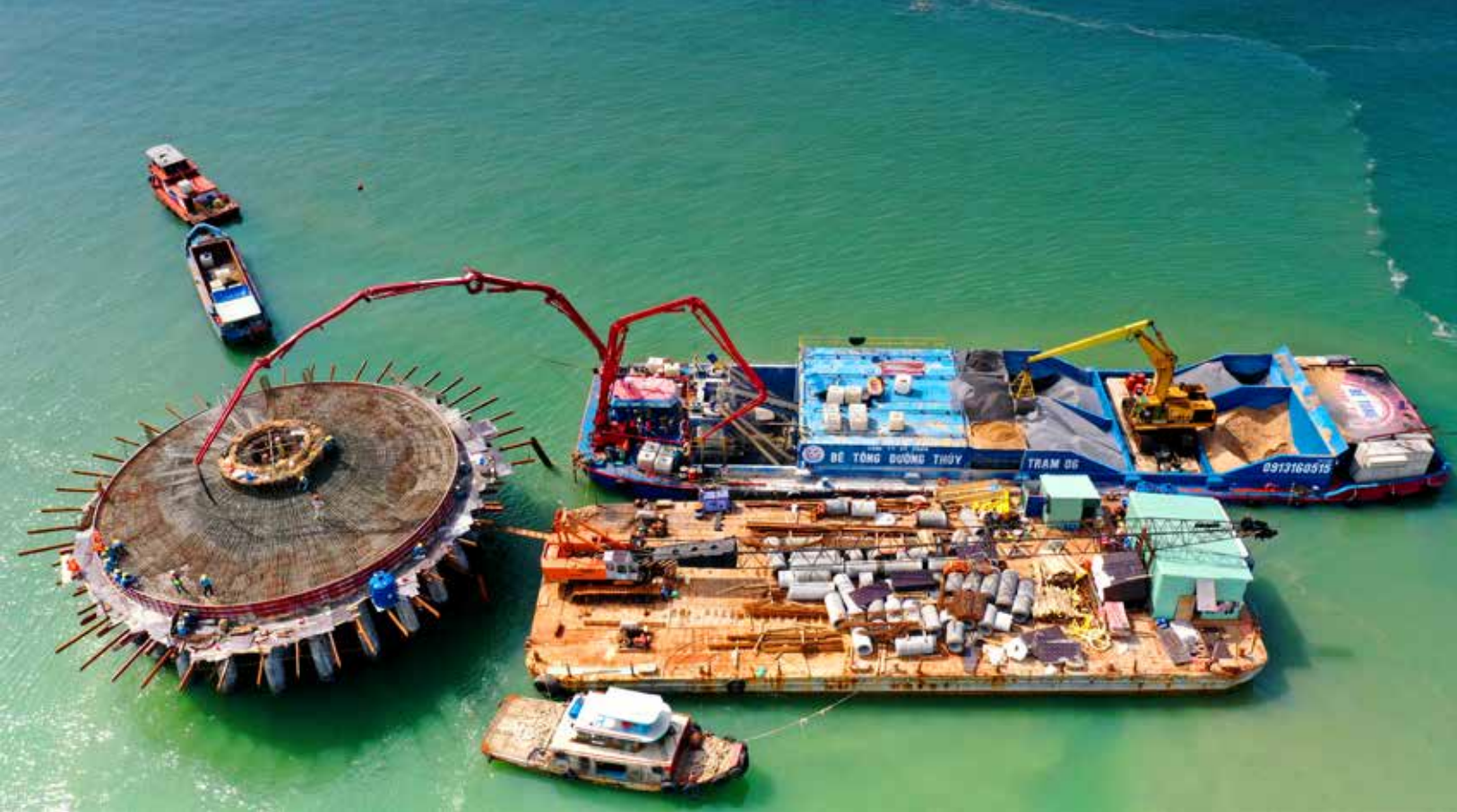
Bê tông Đường Thủy thực hiện công tác cấp bê tông tươi cho bệ móng trụ điện gió.
