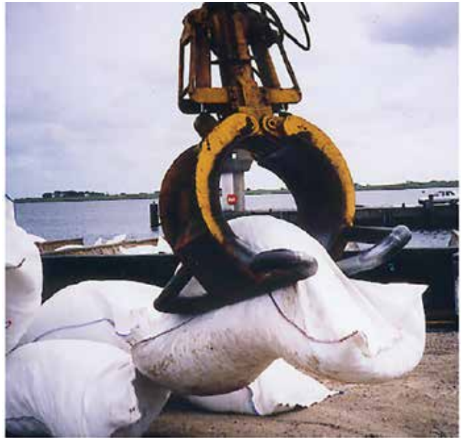
Hình 5. Thi công, cho cát vào và may kín các bao địa tại “Eidersperrwerk” (1993).
