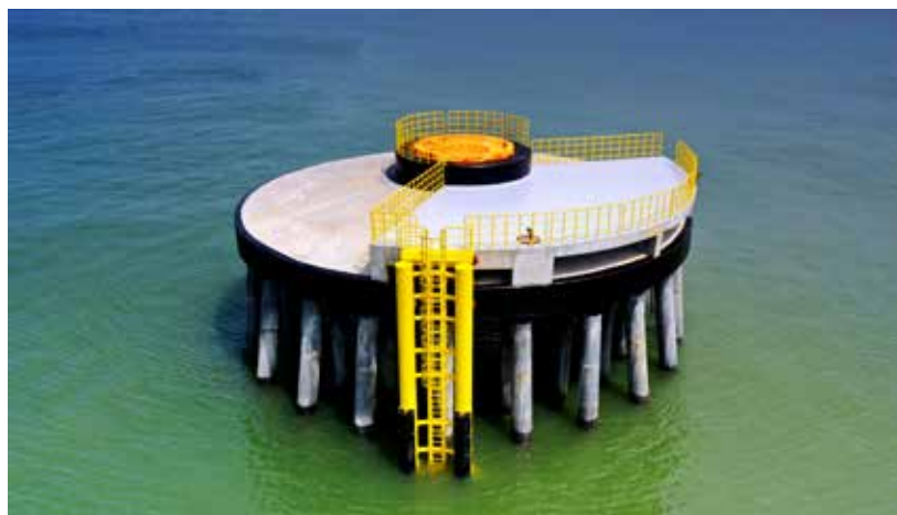
Một bệ móng trụ điện gió hoàn thiện.
