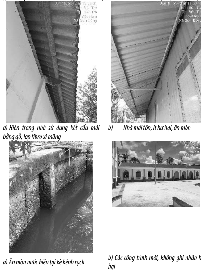
Hình 5. Hiện trạng các công trình khảo sát tại Bến Tre
