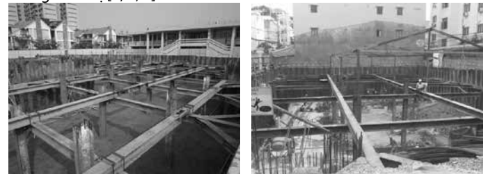
Hình 1: Tường cừ Larsen hố đào sâu
