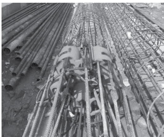
Hình 3. Công trình 18 Điện Biên Phủ - cọc D800 - lắp đặt thiết bị O-cell và thi công hạ cọc
