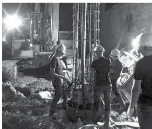
Hình 3. Công trình 18 Điện Biên Phủ - cọc D800 - lắp đặt thiết bị O-cell và thi công hạ cọc
