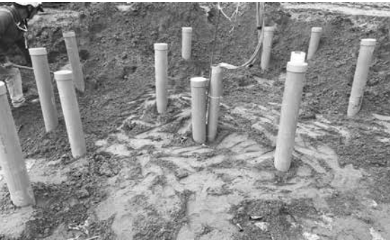
Hình 8. Hình ảnh lắp đặt thiết bị
