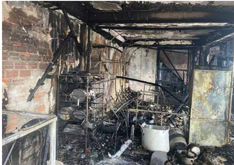
Hình 4. Vụ cháy đã thiêu trụi hoàn toàn căn nhà trên đường Lạc Long Quân, quận 11, TP.HCM và làm chết 8 người.
