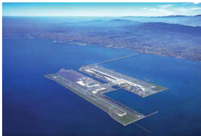
Hình 2: Sân bay Kansai được xây dựng trên đảo nhân tạo. Ảnh: Internet
