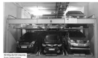
Hình 3. Hệ thống đỗ xe kiểu 2 tầng hoán đổi vị trí
