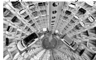
Hình 1. Hệ thống đỗ xe kiểu trụ đứng
