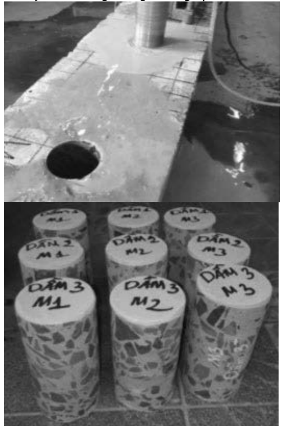
Hình 3. Lấy mẫu bê tông trên các mẫu dầm
