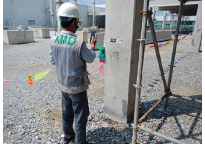
Cập nhập trạng thái sản xuất, thi công cấu kiện thông qua các ứng dụng QR Code tại Công ty CP Đầu tư xây dựng Xuân Mai.
