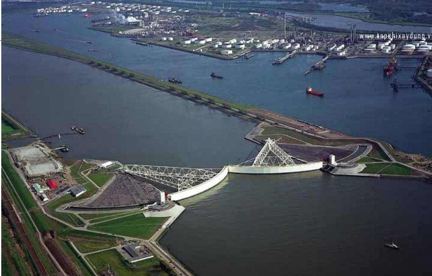
Hình 1: Đập chắn sóng ngăn nước từ biển Bắc, Hà Lan. Ảnh: Kering huis.
