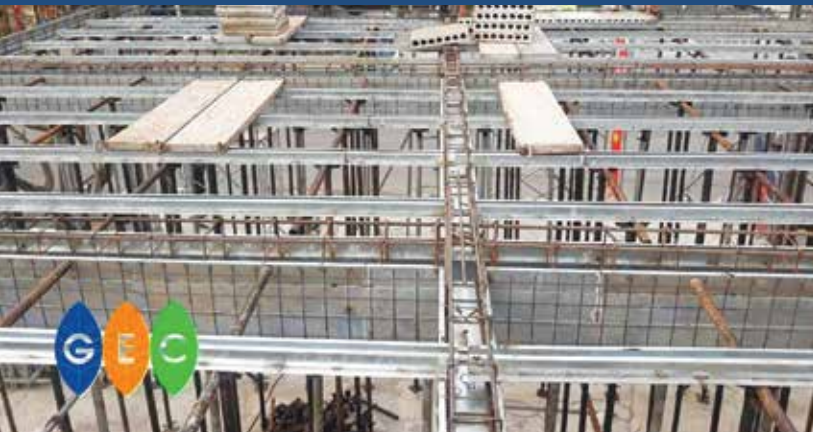
Hình 2. Các bộ phận kết cấu dầm cột GuBeam.
