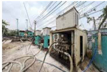
Hệ thống bơm áp suất và thiết bị khuấy trộn thi công Jet Grouting.
