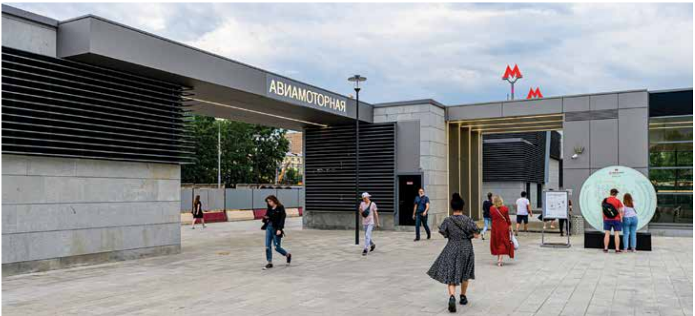
Hình 4. Tháp thông gió kết hợp với lối ra vào sảnh trên mặt đất của ga ngầm tạo hiệu ứng thẩm mỹ tại ga Aviamotornaya - tuyến Vòng Tròn Lớn tại Mát-xcơ-va.
