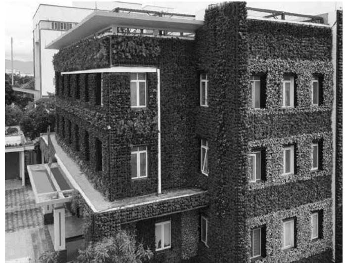
Hình 18. Mảng tường xanh đứng và vườn trên mái tại Tòa nhà Ban quản lý dịch vụ công ích Đồng Hới sau khi hoàn thành [8]
