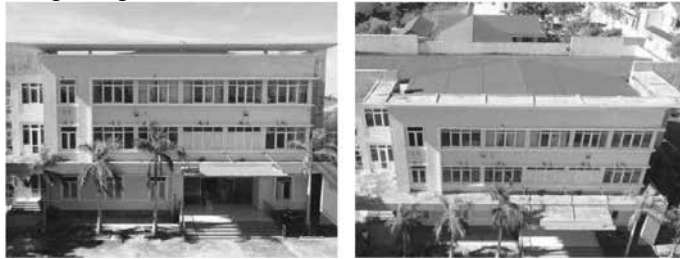
Hình 16. Mặt tiền (trái) và mái của Tòa nhà BQL (phải) [GIZ]
