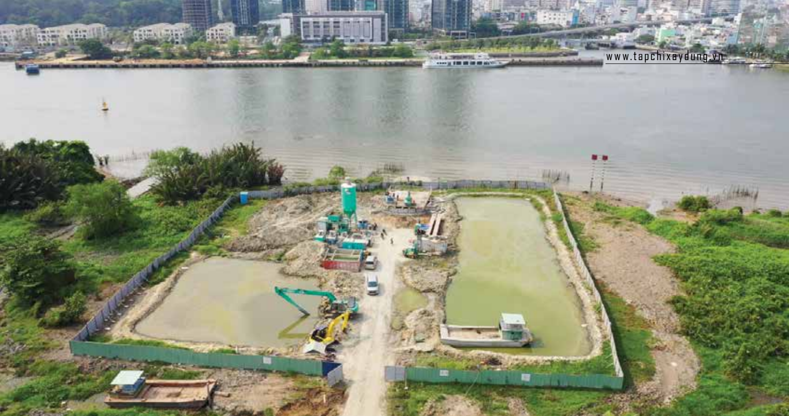
Khu vực thi công dự án VSMT - gói XL01.
