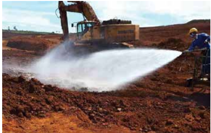
Sử dụng hóa chất DHD 101 gia cố mặt nền ở Tây Nguyên.
