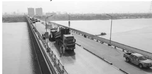
Hình 17. Dự án sửa chữa mặt cầu Thăng Long bằng UHPC
