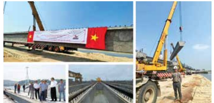
Hình 2. Một số hình ảnh các công trình đã sử dụng dầm U bê tông cường độ cao DUL căng trước
