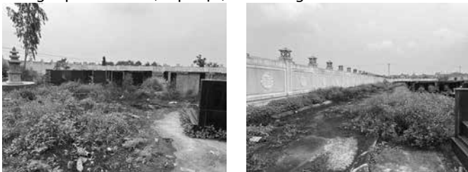
Hình 2.3. Thực trạng hạ tầng kỹ thuật tại nghĩa trang nhân dân xã Tiên Dương, huyện Đông Anh
