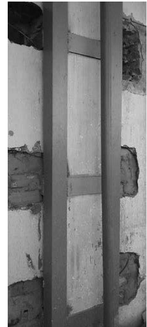
(b) Hình ảnh thi công thực tế
