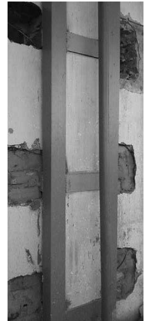
(b) Hình ảnh thi công thực tế
