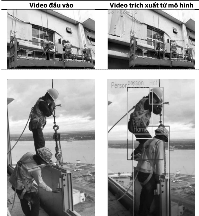
Hình 7. Kết quả nhận diện đối với công tác lắp đặt hệ mặt dựng
