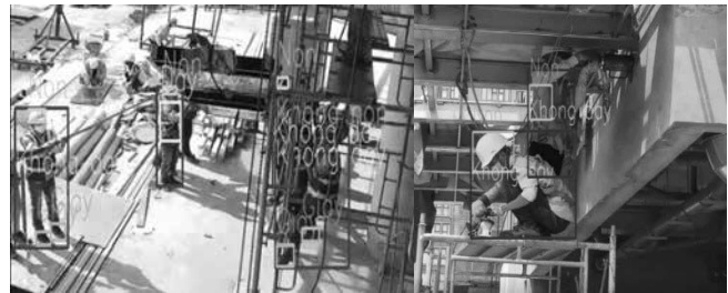
Hình 6. Hình ảnh từ dự án thực tế
