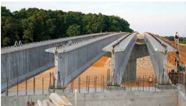
Hình 11. Dầm cánh rộng (mặt cắt chữ I) đang được thiết kế, thử nghiệm trong dự án do Aus4Transport tài trợ
