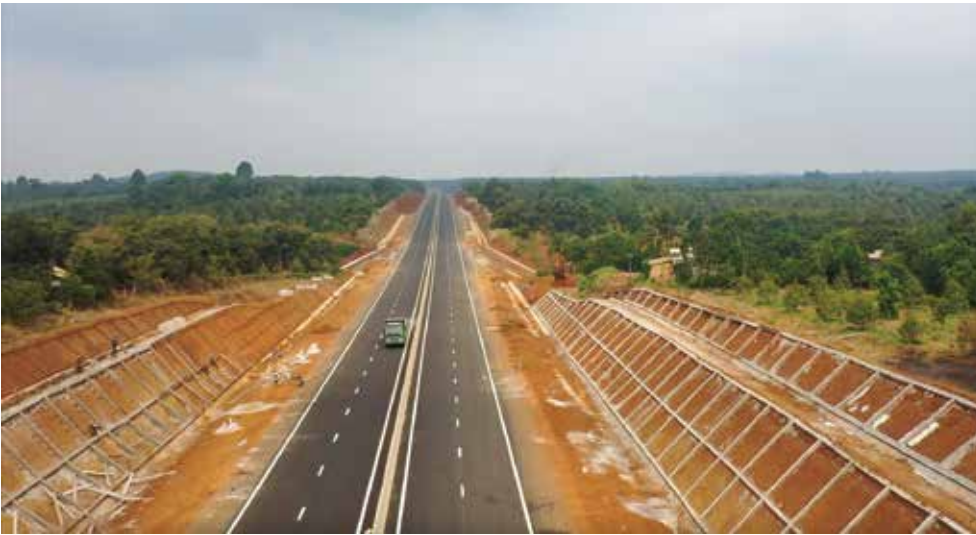
Gói thầu XL03, đoạn qua tỉnh Đồng Nai, các công nhân đang thi công các khung bê-tông tạo mặt bằng trồng cây xanh trên phần ta-luy của tuyến cao tốc.
