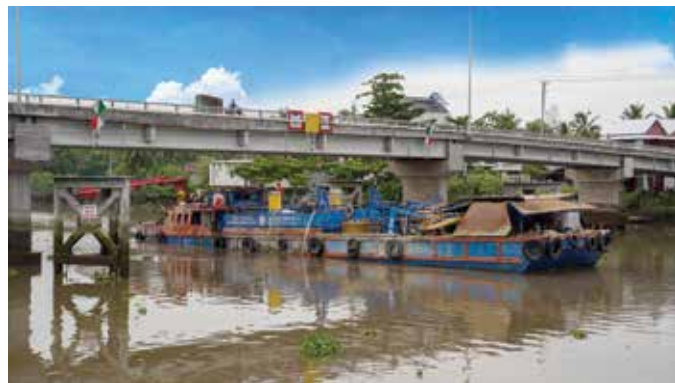
Trạm trộn bê tông di chuyển qua cầu thấp.
