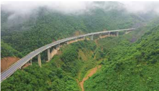
Hình 5. Cầu cao tốc Thái Nguyên - Bắc Kạn.
