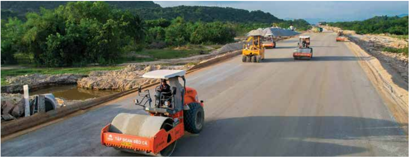
Thi công cao tốc Bắc - Nam đoạn Cam Lâm - Vĩnh Hào.
