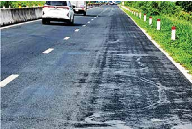
Mặt đường vừa được sửa chữa.
