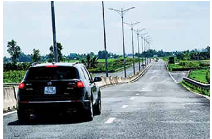
Lùn kết cấu nền và mặt đường ở một nút giao dự kiến.
