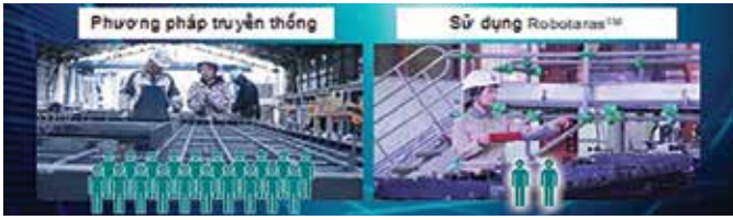
Hình 3. So sánh về năng suất lao động giữa phương pháp lắp đặt cốt thép truyền thống và sử dụng hệ thống Robotaras™ (Hình ảnh được tham khảo trong tài liệu giới thiệu sản phẩm cung cấp bởi Công ty Sumitomo Mitsui Construction Co., Ltd).
