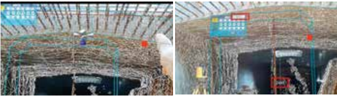
Hình 8. Ứng dụng của GyroEye Holo và thiết bị MR HoloLens trong việc đo kích thước ván khuôn.
