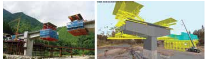
Hình 4. Công nghệ MR giúp đưa mô hình 3D của công trình ra ngoài thực tế. ( https://ken-it.world/success/2019/11/kuzuryu-river-bridge.html )
