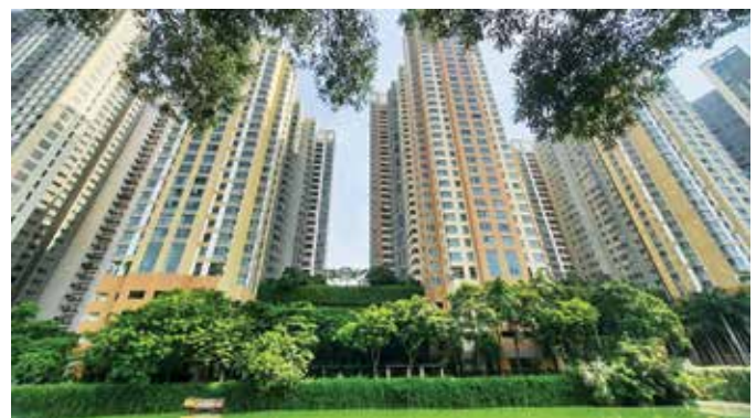
Hình 4: Tòa nhà chung cư cao tầng Mulberry Lane (Hà Nội) với không gian tầng trệt và tầng mái khối để có diện tích bố trí tiểu cảnh cây xanh, không gian vui chơi, bể bơi, luyện tập thể thao, tượng điêu khắc trang trí đặc sắc, được Singapore cấp giấy chứng nhận “Tòa nhà đạt tiêu chuẩn thân thiện với môi trường” BCA Green Mark năm 2014 (nguồn: tác giả)
