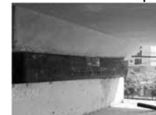
b) Cầu trên tuyến ĐSĐT Bến Thành - Suối Tiên
