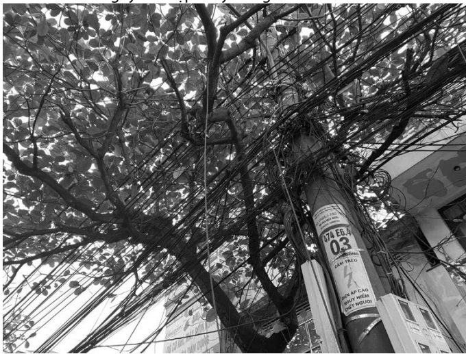
Hình 2. Bàn giao hòa của cây xanh và hạ tầng kỹ thuật luôn tiềm ẩn nguy cơ chập cháy trong mùa mưa bão - Hình ảnh tại tại số nhà 201 đường Bến Oánh, phường Túc Duyên, TP Thái Nguyên. (Phạm: 2023)
