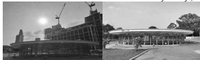
Hình 2. Trạm Metro số 1 Bến Thành
