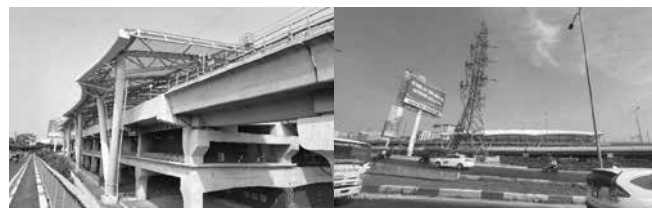
Hình 1. Trạm Metro số 5 - Tân Cảng
