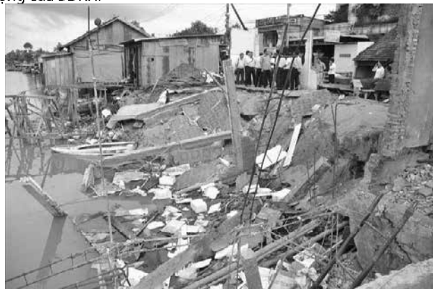
Hình ảnh những căn nhà bị sập xuống dòng sông ở khu vực ĐBSCL
