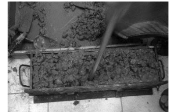
Hình 11. Đổ bê tông vào khuôn và đầm chặt
