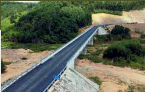
Đoạn tuyến Đường Trường Sơn Đông đã hoàn thành chạy theo sườn núi.
