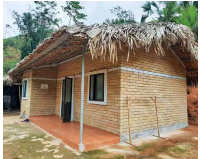
Một trong những ngôi nhà được xây dựng bằng gạch đất không nung tận dụng từ nguyên liệu tại chỗ của địa phương.
