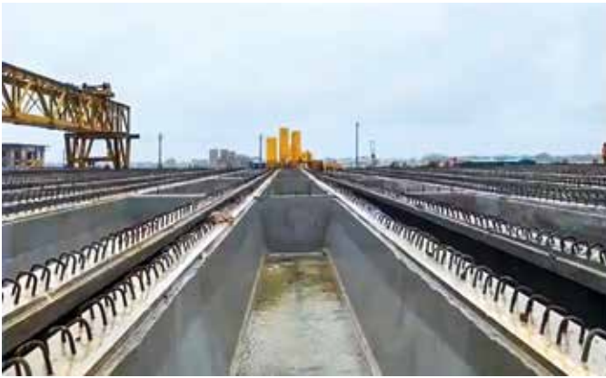
Thi công dầm U cầu đập Trà Khúc, tỉnh Quảng Ngãi.
