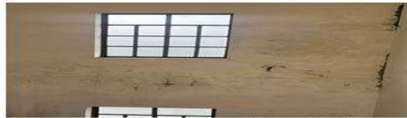
Hình 3.9. Mặt tường sau cầu thang tầng 2-3 nhà hiệu
