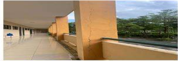
Hình 3.18. Cột hành lang khoa Y Dược nhiều vết nứt dọc
