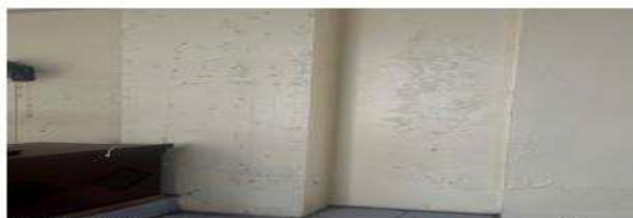
Hình 3.11. Tường cột trong phòng học giảng đường nhà B bị phồng rộp
