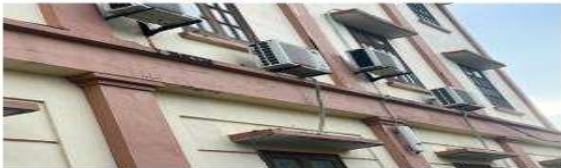
Hình 3.8 Nứt và gỉ sét tại khu vực lắp điều hòa nhà hiệu bộ A
