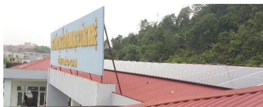
Hình 1. Tấm PIN được lắp đặt áp mái trên các mái tôn bằng các thanh ray đỡ
