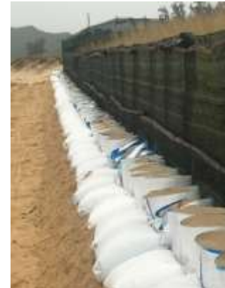
Hình 13: Bao cát vải địa kỹ thuật gia cố chân hàng rào và chống xói chân cồn cát
