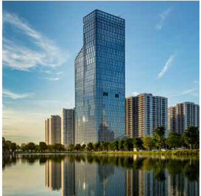
▲ Hình 1. Tòa nhà Techno Park Tower, Vinhomes được xây tại huyện Gia Lâm, Hà Nội được cấp chứng chỉ CTX LEED Kim cương năm 2022
