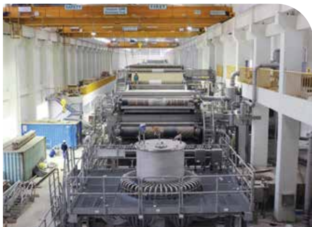
▲ Hệ thống dây chuyền sản xuất giấy tại Nhà máy An Hòa
