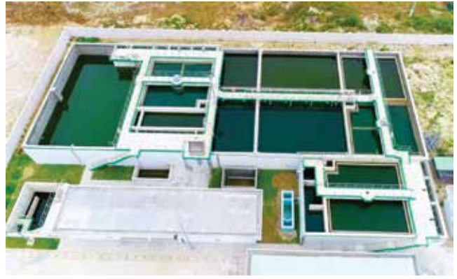
▲ Khu xử lý nước thải KCN Tam Thăng 2, Quảng Nam
