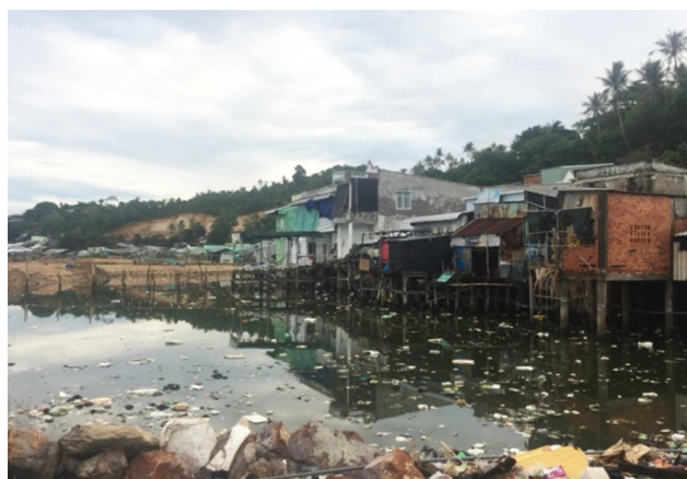
Hệ thống nước thải năm 6/2020
