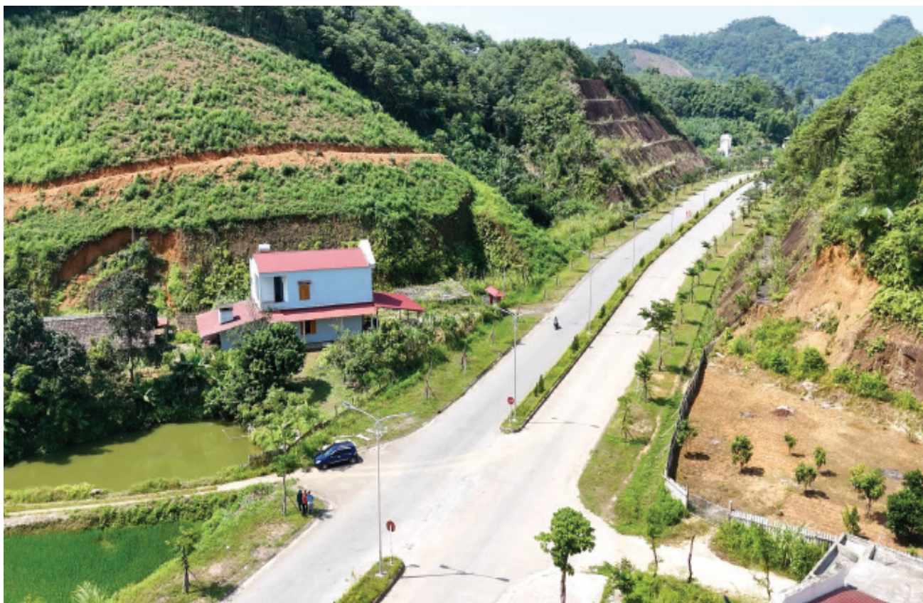
Hệ thống đèn chiếu sáng được trang bị tại tuyến đường Đồng Luộc, Phúc Hương, xã Chiêm Hóa, tỉnh Tuyên Quang
