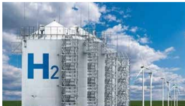
▲ Nhà máy sản xuất hydrogen xanh đầu tiên sẽ đặt tại tỉnh Bến Tre dự kiến vận hành chạy thử nghiệm vào quý I/2024
