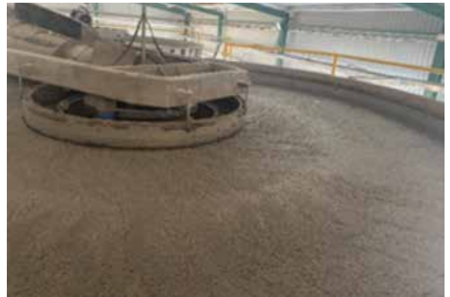
▲ Hình 1. Bùn giấy được thu gom tại bể tuyển nổi của hệ thống xử lý nước thải
