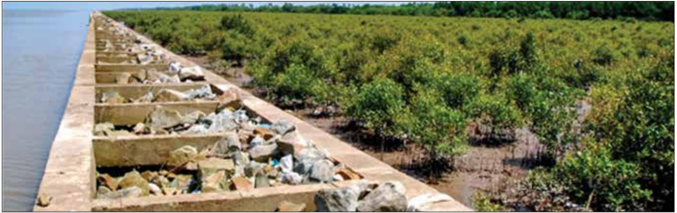
▲ Rừng phòng hộ được bảo vệ bằng các kè chắn sóng ven biển tại Cà Mau
