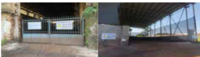
▲ Hình 4. Kho F4 chứa bụi lò 1.426 m 2 và Kho chứa bụi lò 2.644 m 2
