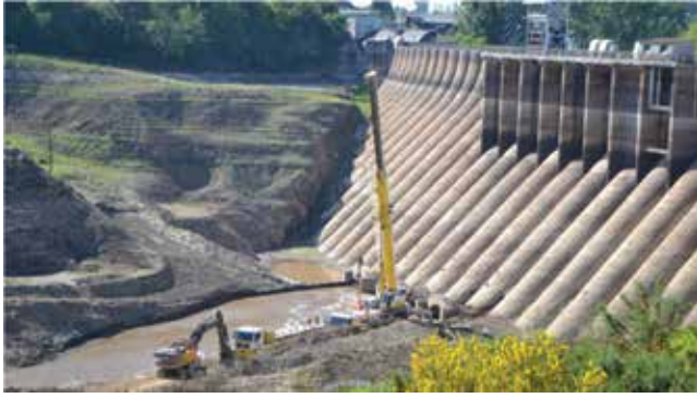
▲ Phá dỡ đập Vezins cao 36m trên sông Sélune (Pháp)
