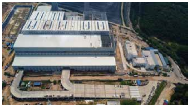
▲ Nhà máy Điện rác Thiên Lý, Sóc Sơn, Hà Nội, vốn đầu tư khoảng 7.000 tỷ đồng, công suất đốt rác 5.000 tấn rác ướt mỗi ngày, công suất phát điện 75 MW
