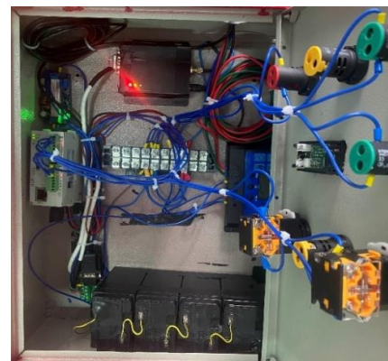
Hình 5. Tủ điều khiển và giám sát phao
